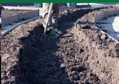
2. Взрыхляем грунт на дне траншеи
