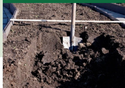
1. Выкапываем траншею по ширине ящиков
